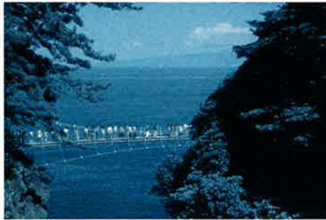
門脇つり橋(Kadowaki Suspension Bridge)
